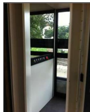
In assenza di porte in cabina viene utilizzata fotocellula a barriera a raggi infrarossi al fine di interrompere il movimento in caso di pericolo. Possono essere applicate inoltre porte a soffietto o telescopiche.
