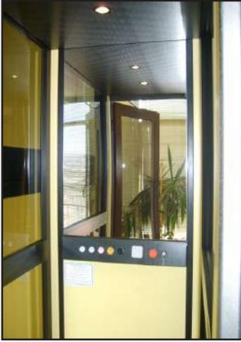
La cabina può essere realizzata in pannelli autoportanti di lamiera plastificata, in lamiera rivestita in laminato plastico oppure in lamiera verniciata colore RAL.
